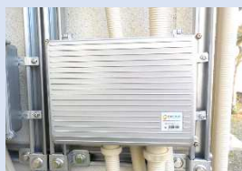
設置したPV計測ユニット
